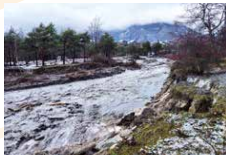
DES BERGES AFFOUILLÉES
