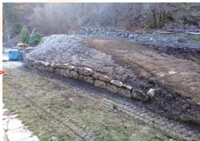
À LA FIN DES TRAVAUX
