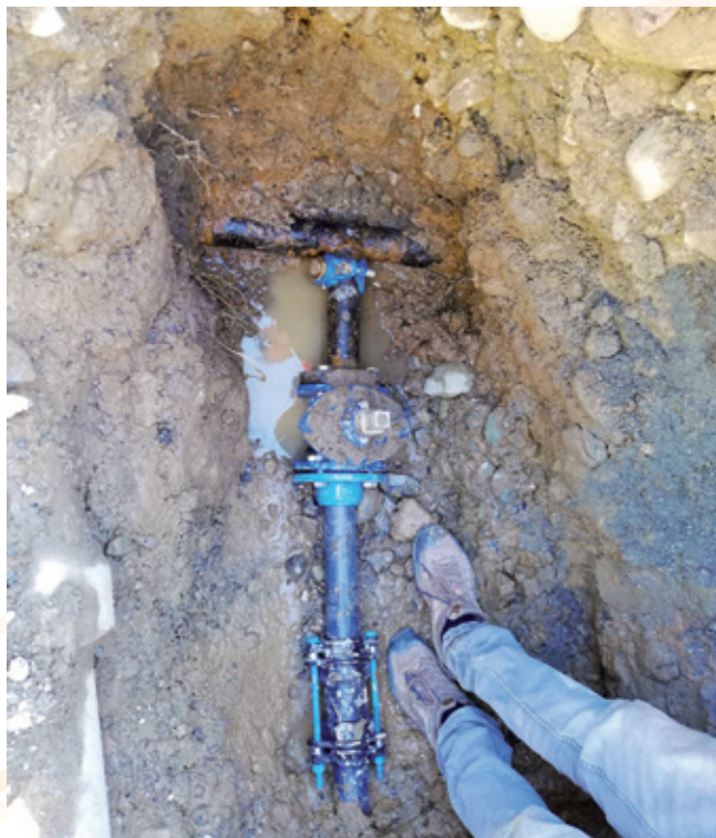
TRAVAUX SUR LE RÉSEAU D'EAU POTABLE
