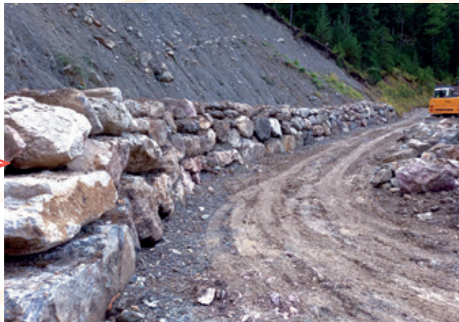
À LA FIN DES TRAVAUX
