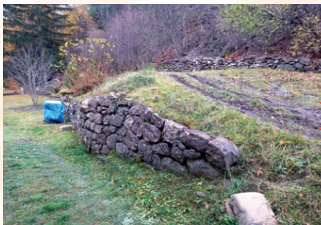
AU DÉBUT DES TRAVAUX
