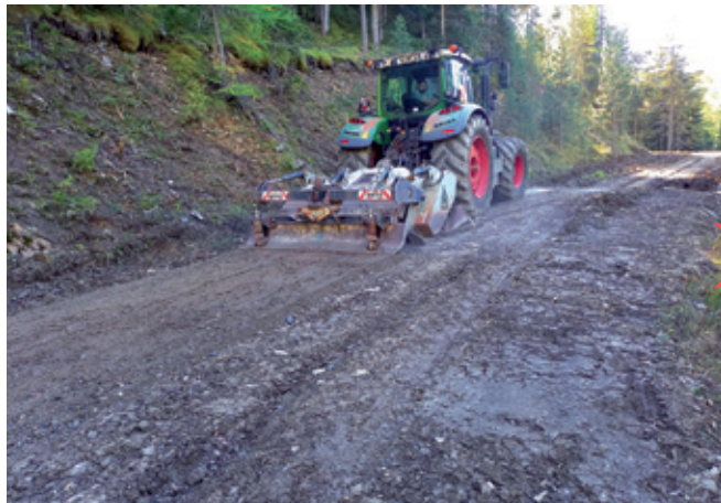
AU DÉBUT DES TRAVAUX
