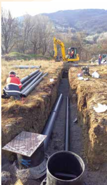
DES RÉPARATIONS INDISPENSABLES POUR SÉCURISER LA DISTRIBUTION EN EAU DE LA COMMUNE
