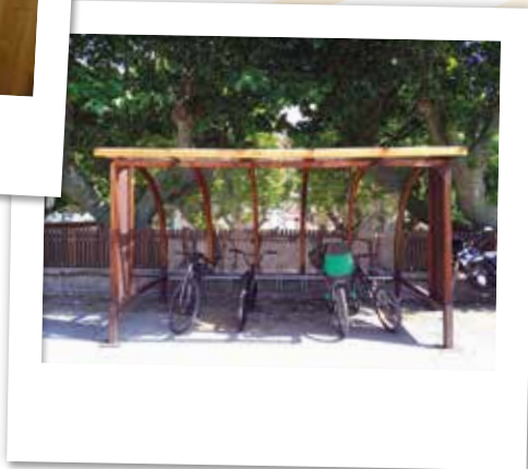
INSTALLATION D'UN ABRI VÉLO
