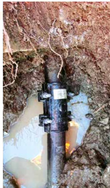
RÉPARATION DE FUITE ET DE CASSE À BRAMOUSSE
