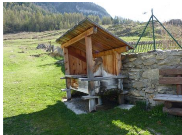
Photographie 109 : Fontaine et banc au Pontet
