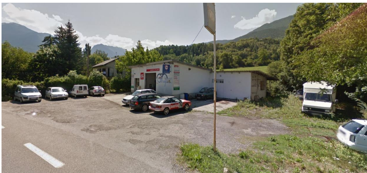
La zone Ae du garage (zonage approuvé, puis extrait zonage + orthophoto) et photo de la construction
