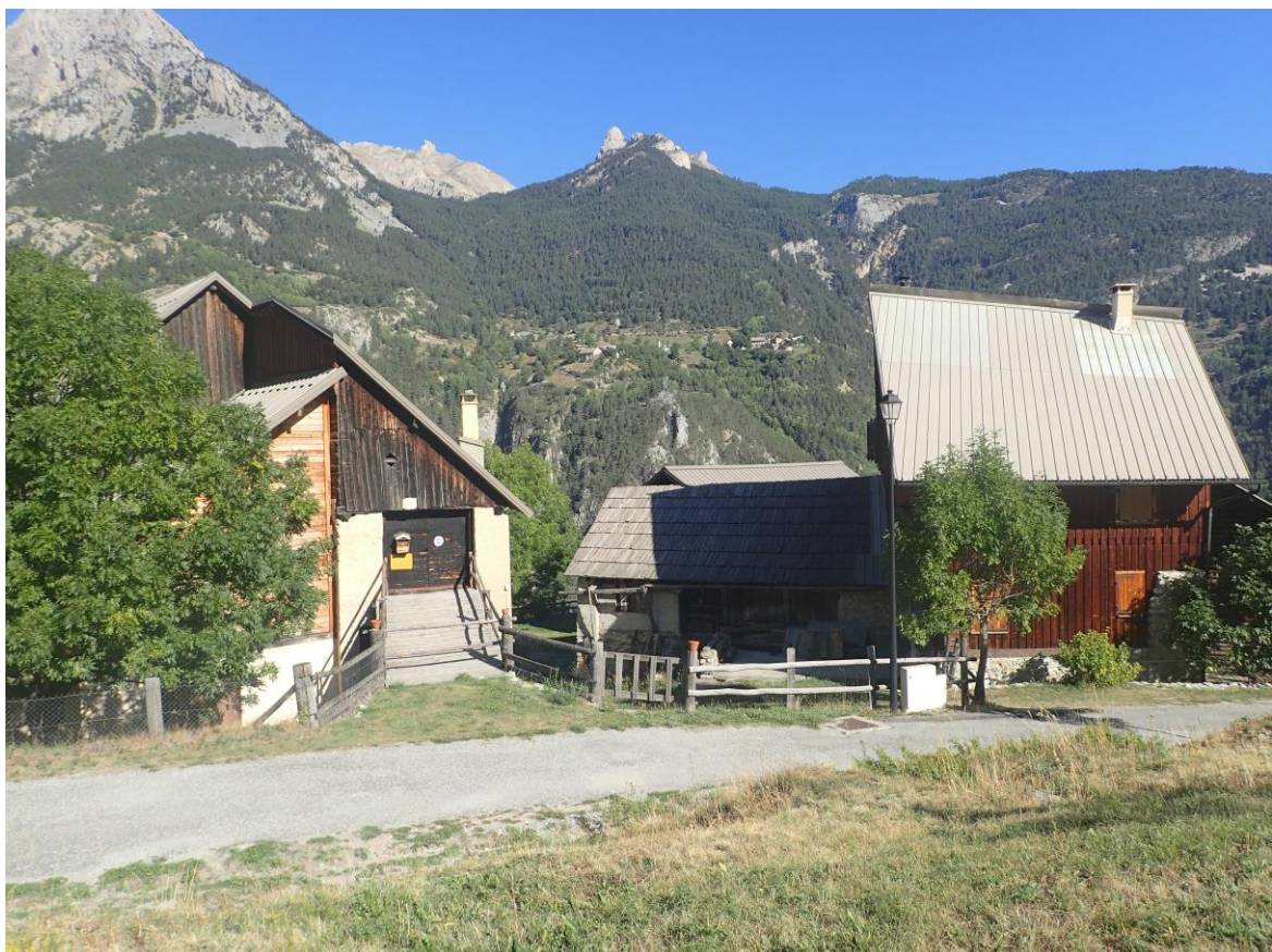
Photographie 142 : Détail de chalets sur Bramousse (avec différents niveaux de rénovation)
