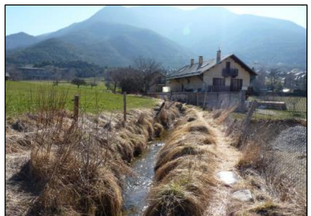
Photographie 78 : Canal d'irrigation
