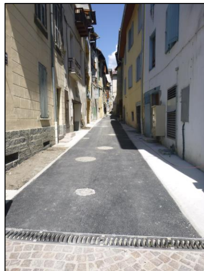
Photographie 98 : La Frairie, rénovée
