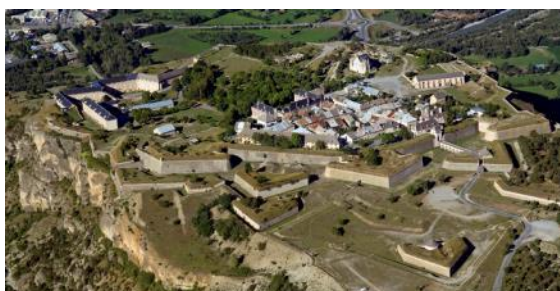
Photographie 77 : Vue aérienne de Mont-Dauphin
